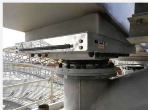
Ložisko Tetron SB využívající ISOGLIDE Stadión Al Bayt - Katar - 2018
