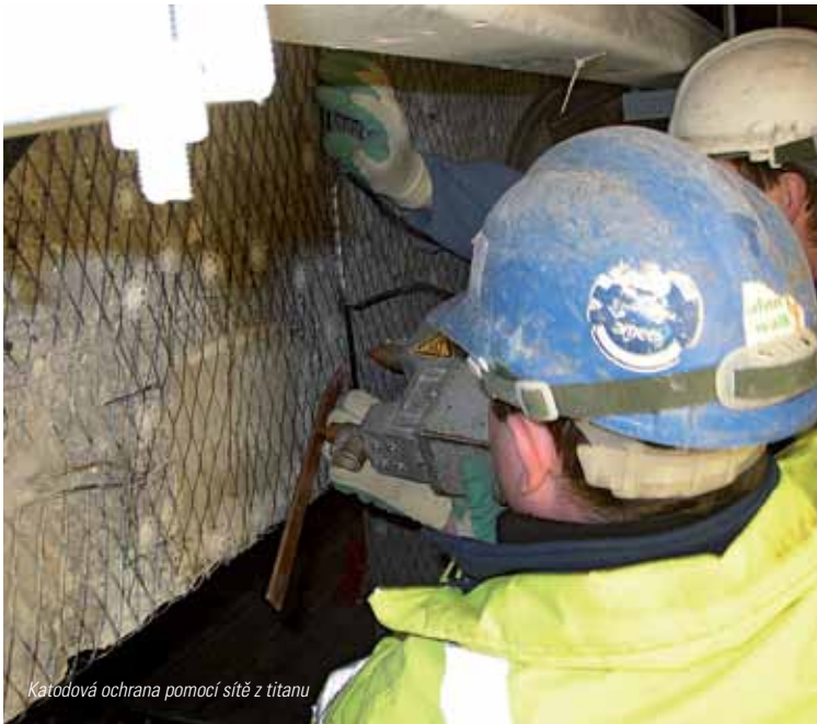
Vodotěsné sanace v cementárně
