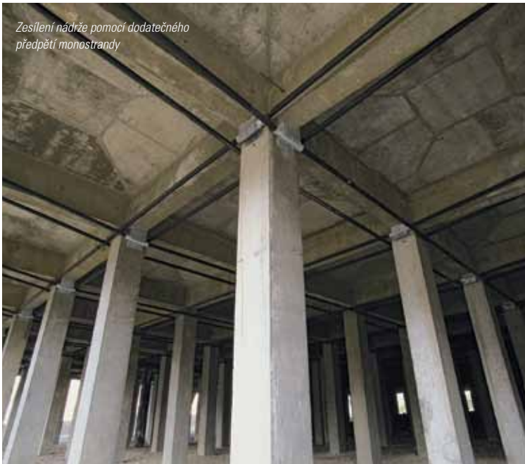
Zesílení věžového vodovodu pomocí dodatečného předpětí monostrandy
