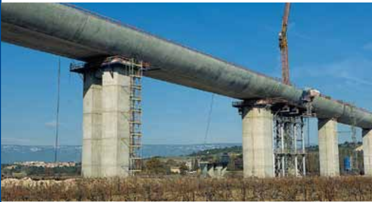
Viadukt Vernégues - trasa TGV - Francie
