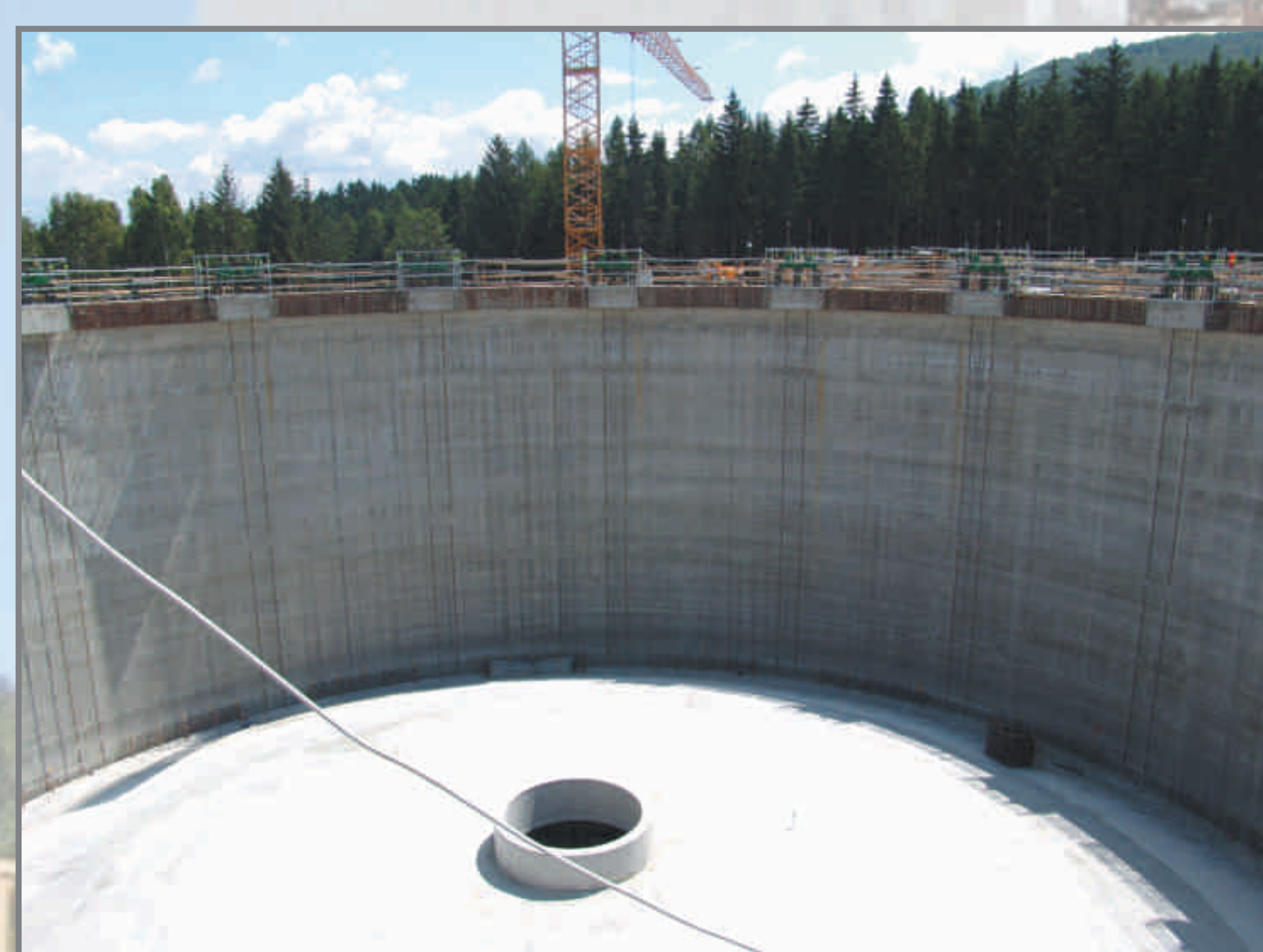
Zdvih stropních skořepin
